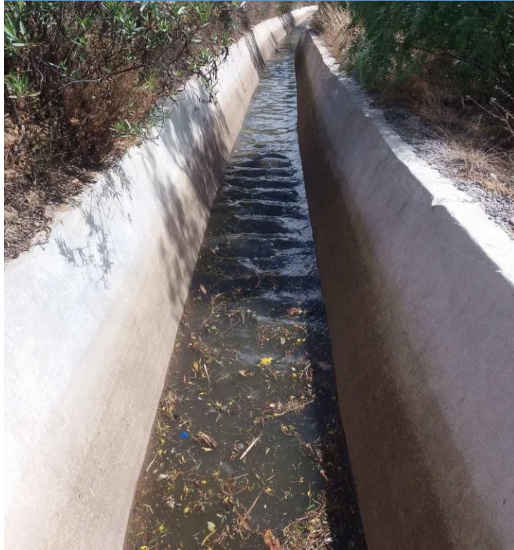
Foto 8. Canal de regadío revestido, por el cual transcurre el agua que es captado en el río Mashcón.
