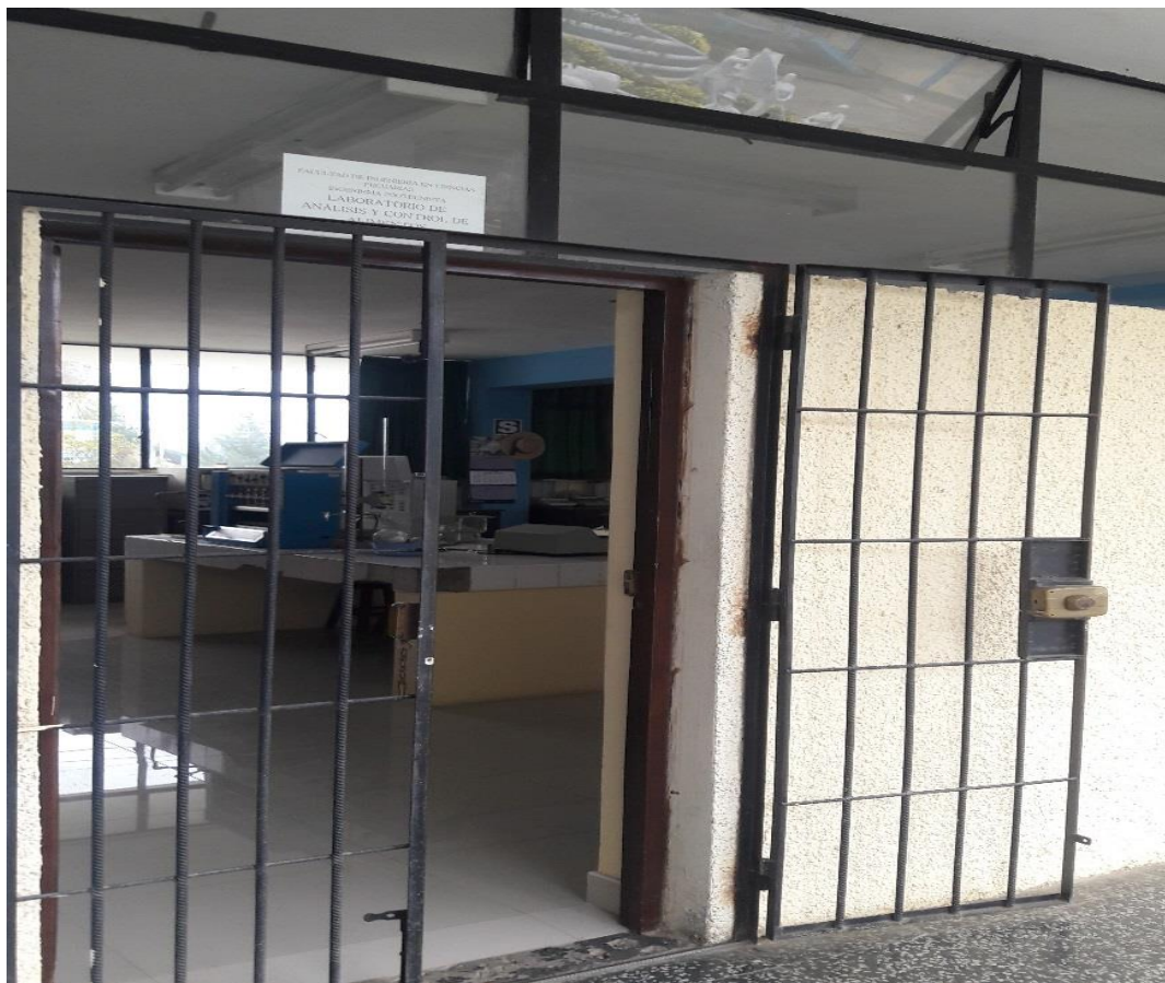
Figura 3: Puerta principal del laboratorio
