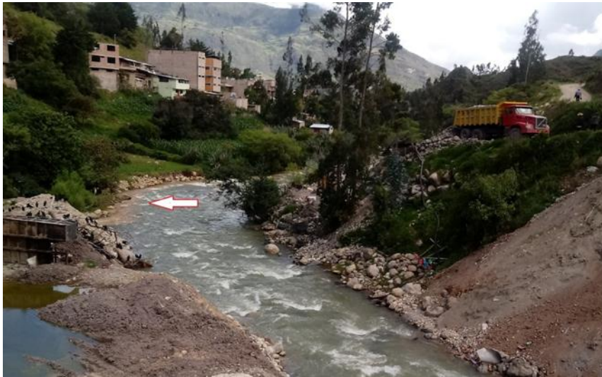
Figura 1: Zona de descarga de las aguas residuales de la ciudad de Bambamarca.
