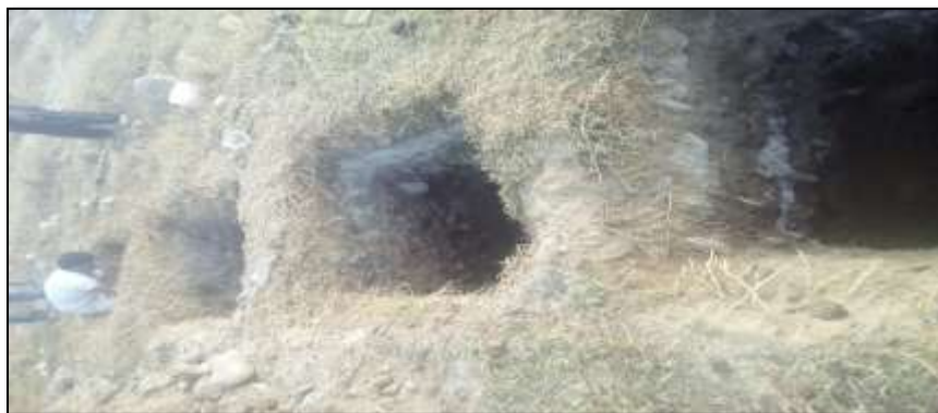
Figura 9: Excavación de celdas para los fitobiorreactores
