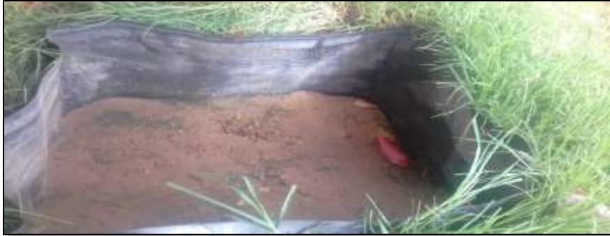
Figura 10: Relleno de Celdas para fitobiorreactores
