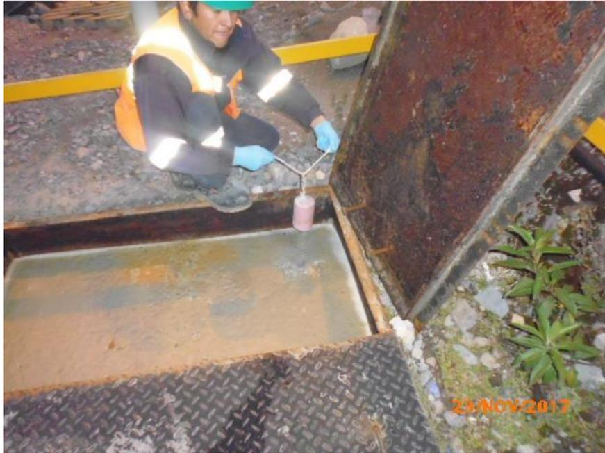
Figura 12 *Instalación de Bioblock 22 en la trampa de grasas Operaciones*
