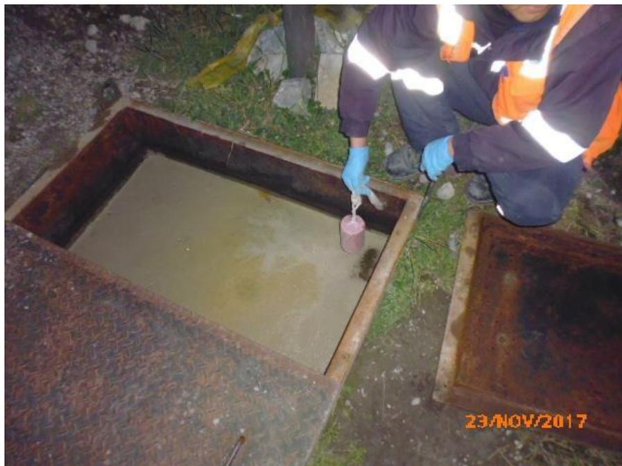
Figura 13 *Instalación de bioblock 22 en la trampa de grasas Arpón*
