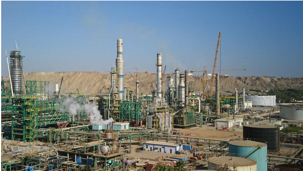
Montaje de estructuras del Proyecto.
