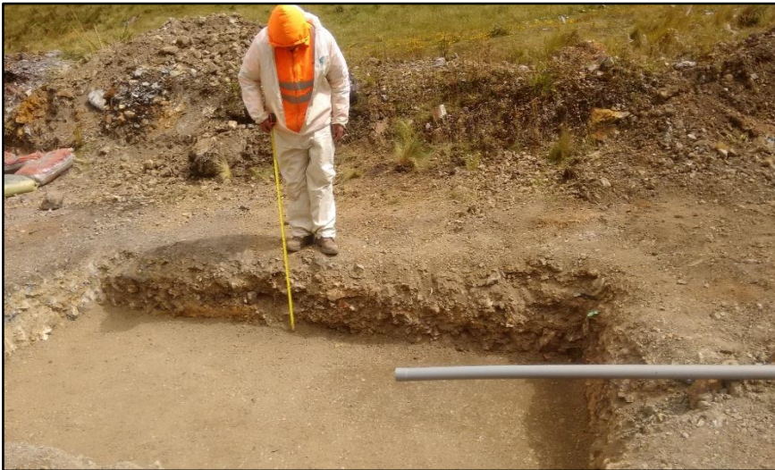
Imagen 5. Relleno y nivelación de celdas
