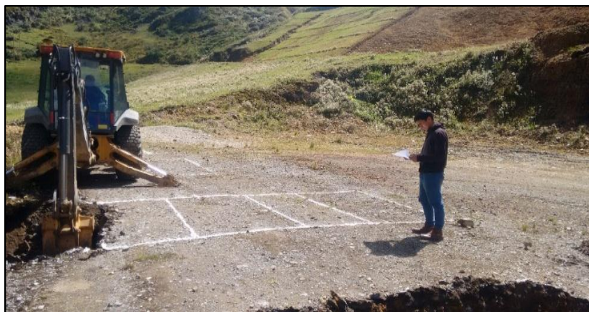
Imagen 2. Excavación de celdas del humedal
