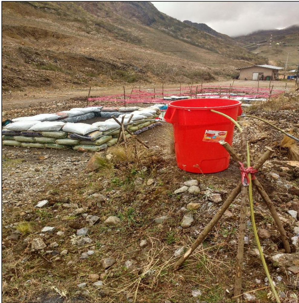
Imagen 14. Incorporación de agua ácida al sistema piloto
