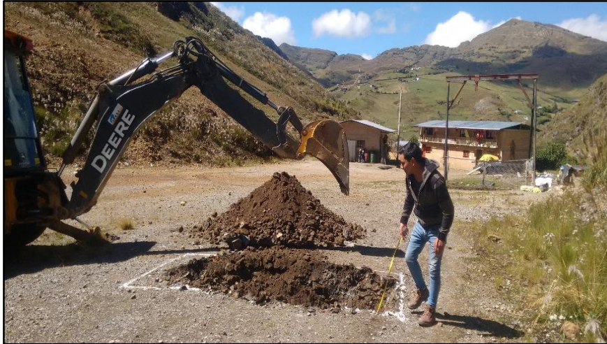
Imagen 3. Verificación de la profundidad excavada
