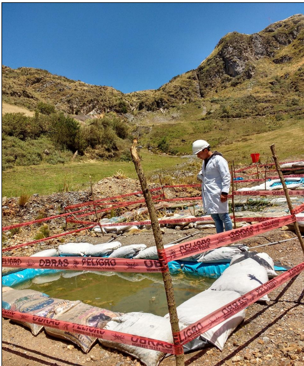
Imagen 13. Sistema piloto de fitorremediación
