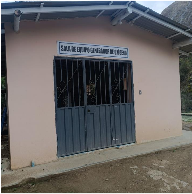
FOTOGRAFÍA 15: Sala de equipo de generación de oxígeno.
