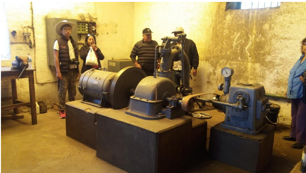
Imagen N° 12: turbinas generadoras de energía elaborada por la Familia Gildemeister aún operativa
