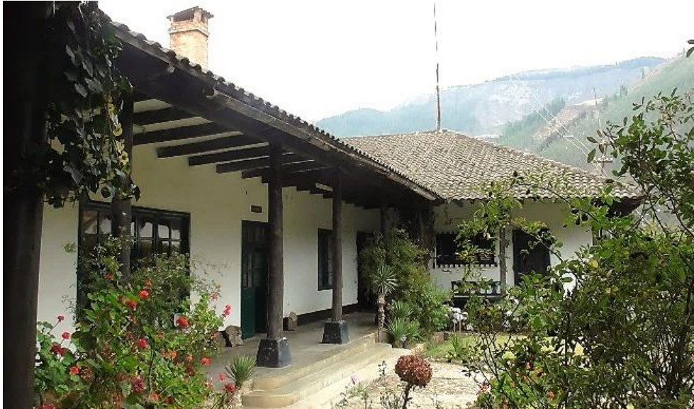
Imagen N° 11: fachada de la Casa Hacienda Huacraruco
