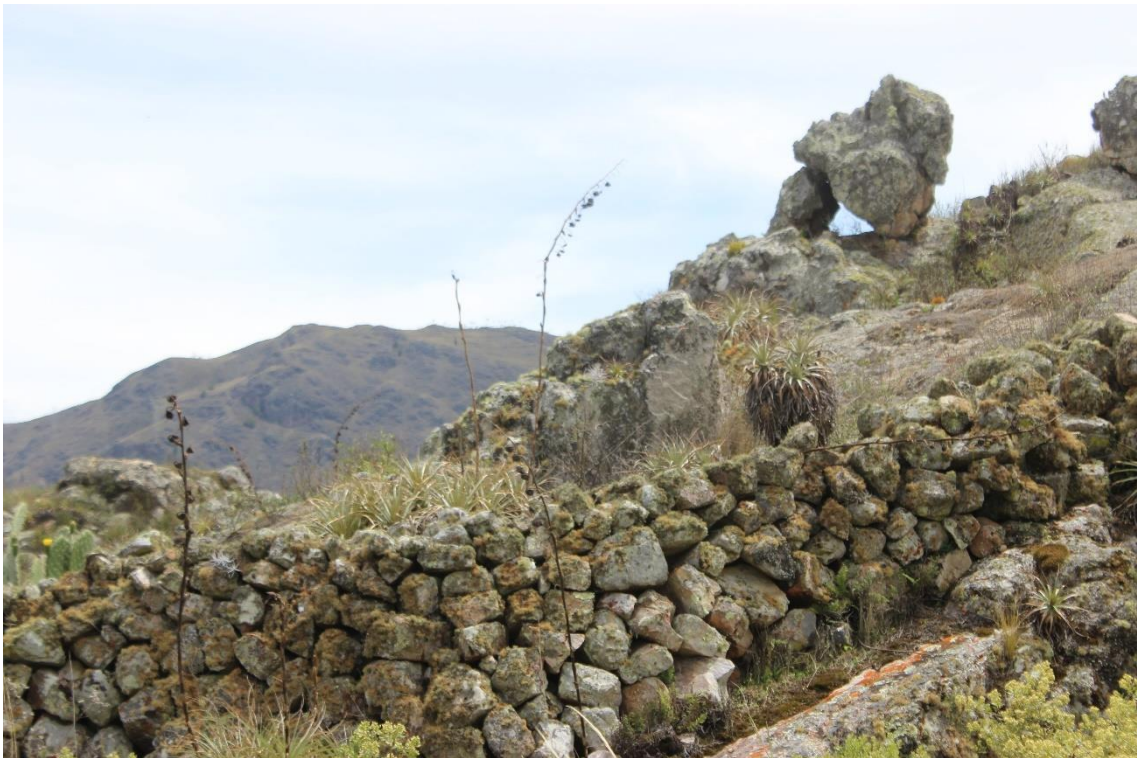
Figura 20: Muros que rodean la tercera terraza.
