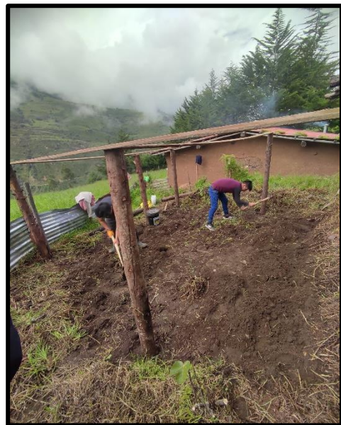
Foto N° 4: Limpieza del terreno para instalar el vivero rustico
