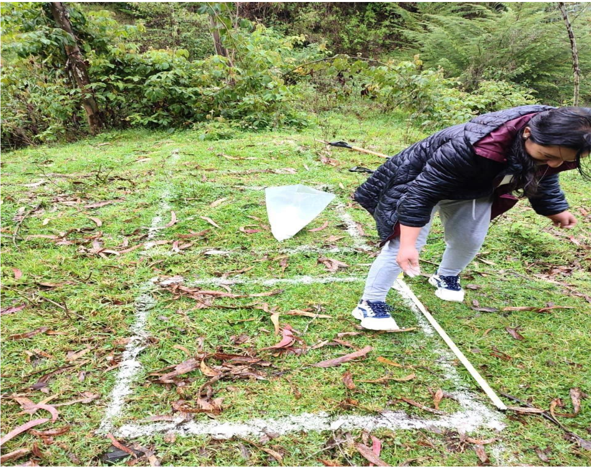
Fotografía 1. Señalización del terreno para la construcción de humedales.
