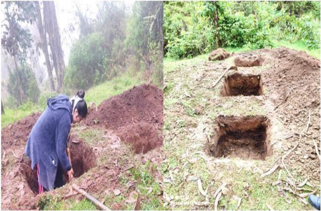
Fotografía 2. Exacavación de hoyos para los humedales.
