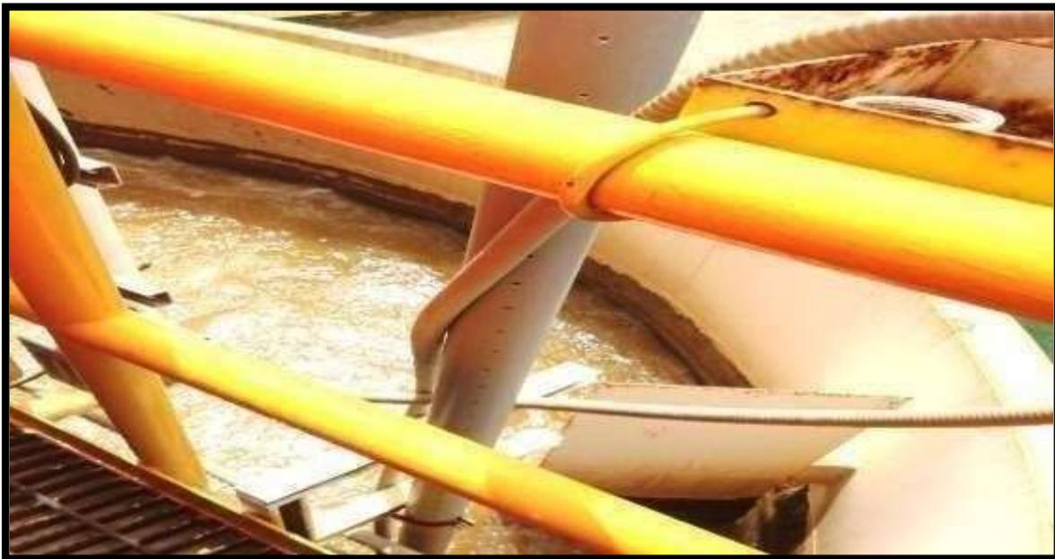
*Figura 16. Punto de donde se tomó la extracción de muestra para realizar la sedimentación del lodo mediante el IVL.*
