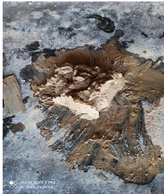
Figura 4: Homogenización de la mezcla
