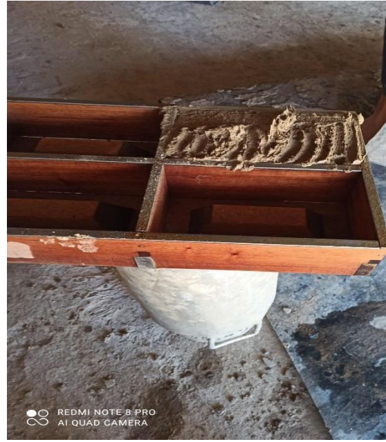
Figura 6: Agregado de la mezcla al molde
