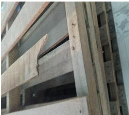
Figura N° 29 Antes de la implementación
