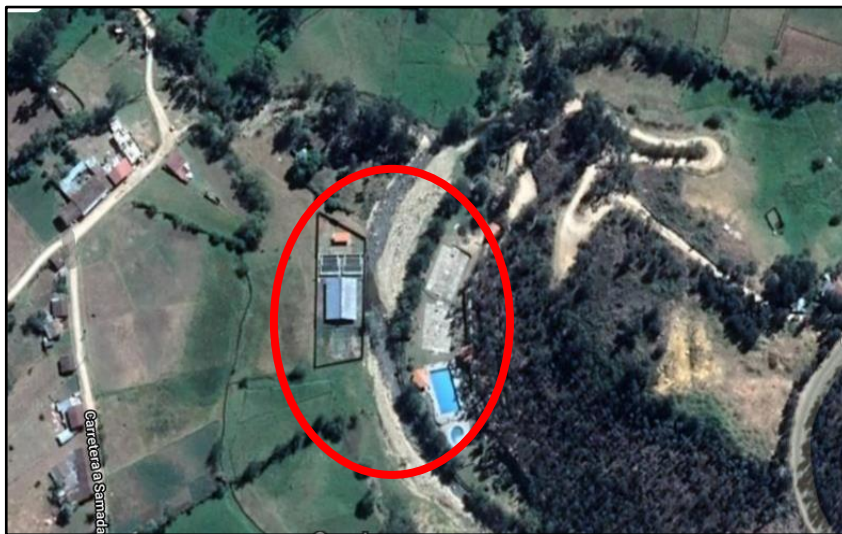
Figura 10: Ubicación de la planta de tratamiento de aguas residuales domesticas
