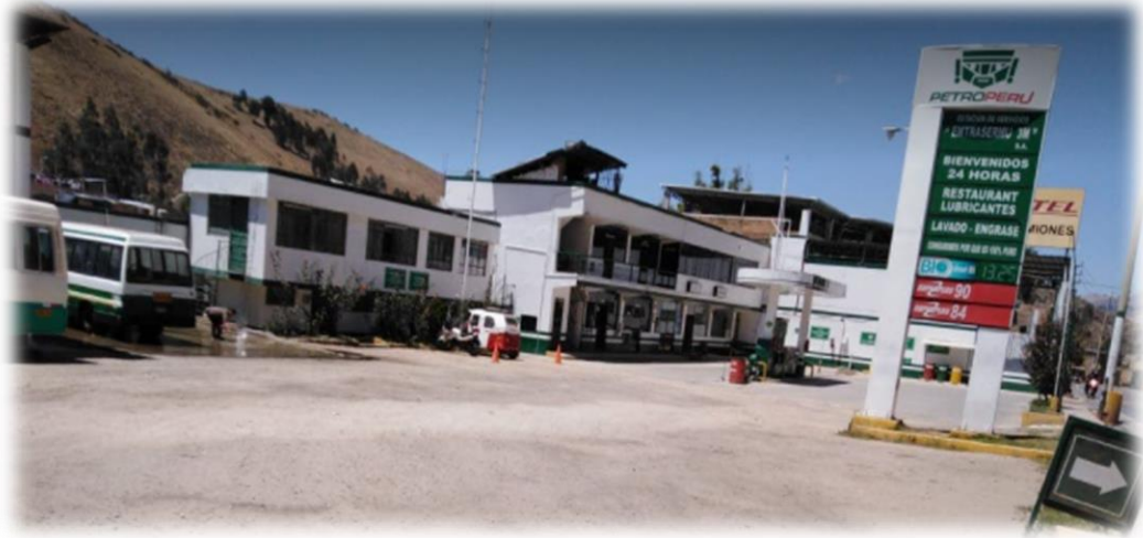
Área: Local de funcionamiento.
