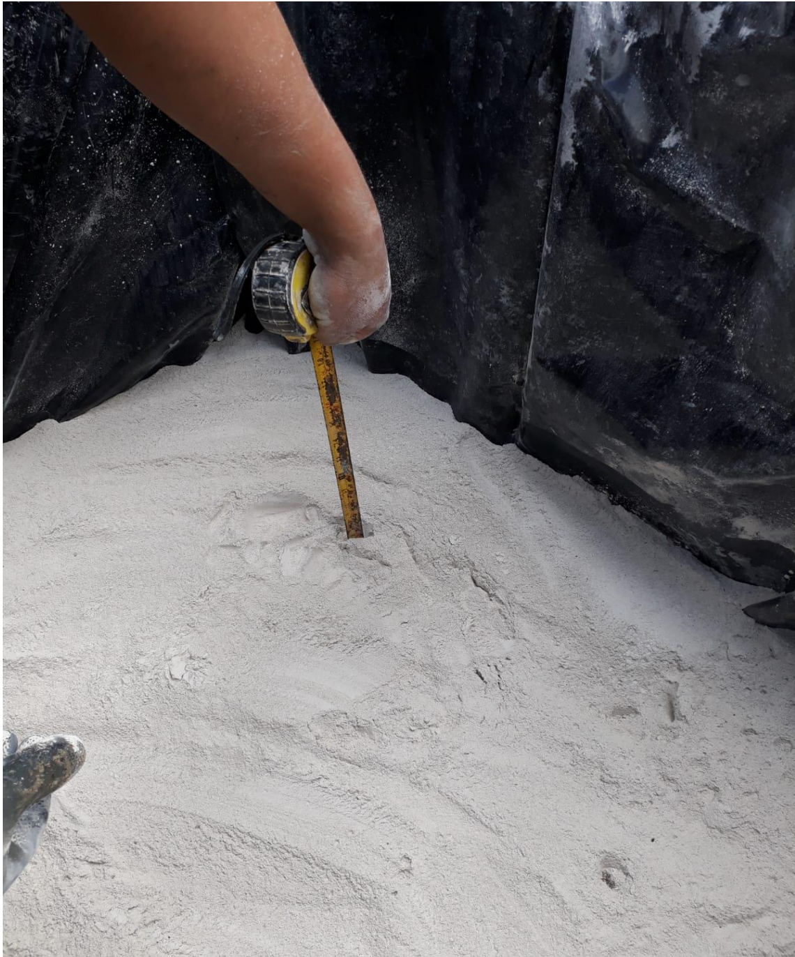
Foto N° 06. Colocación de la capa del óxido de calcio a 40 cm.
