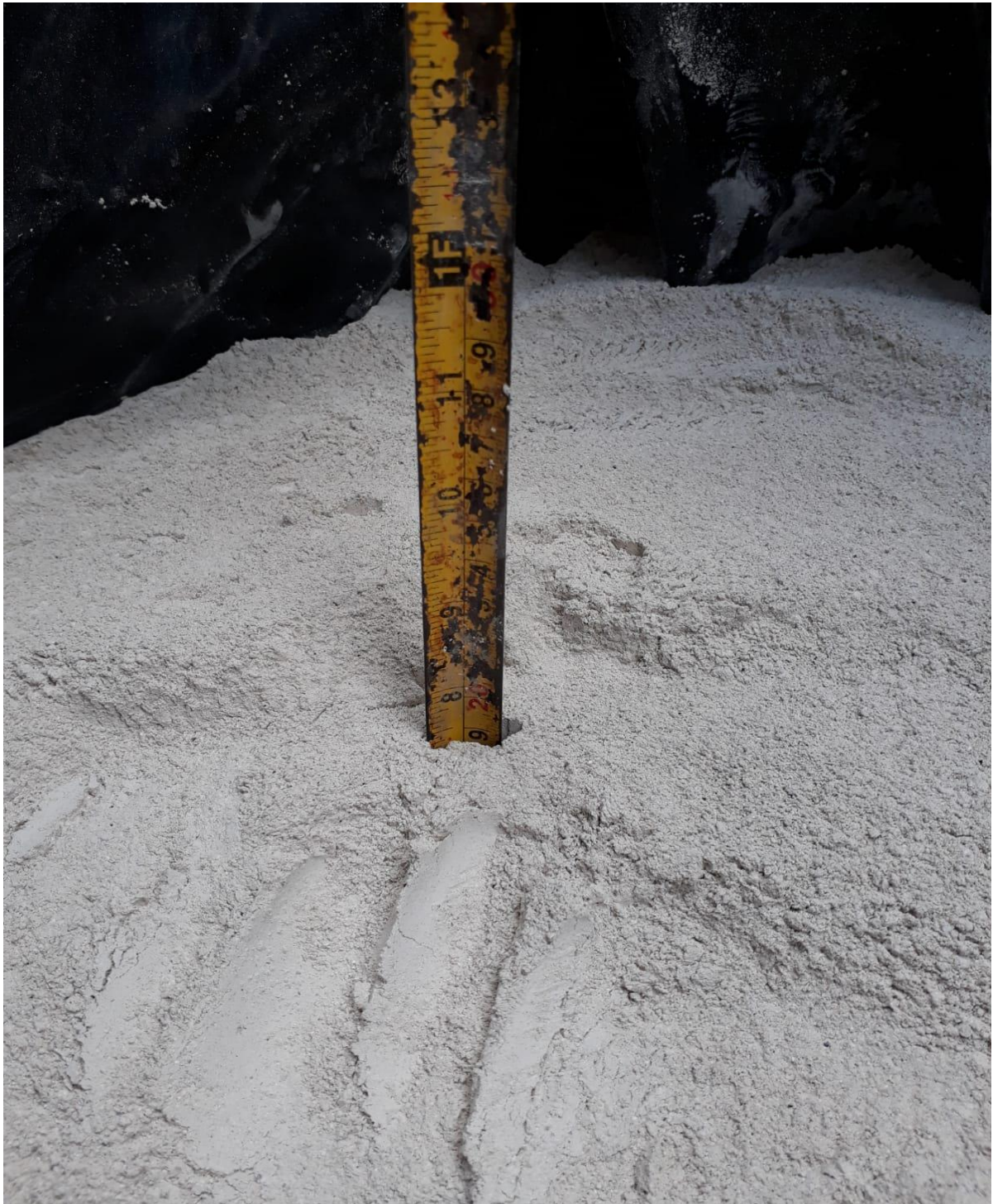
Foto N° 05 colocación del óxido de calcio de 20 cm.
