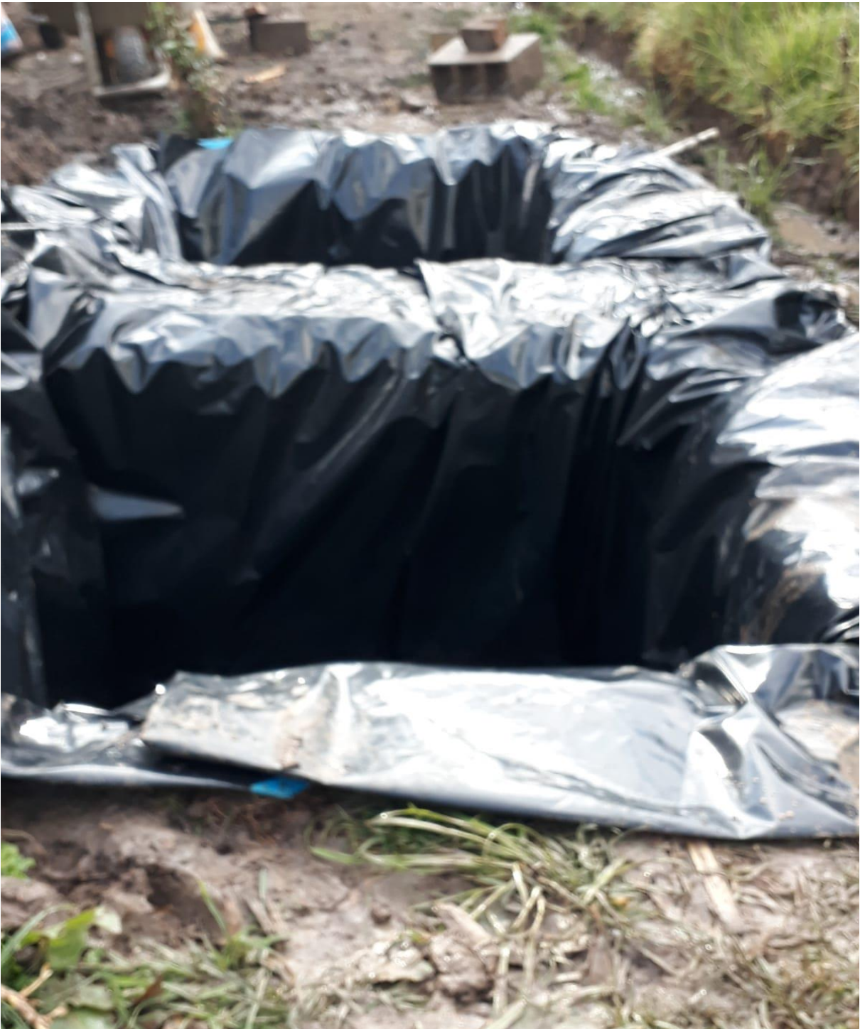
Foto N° 4 colocación de plástico para evitar filtraciones
