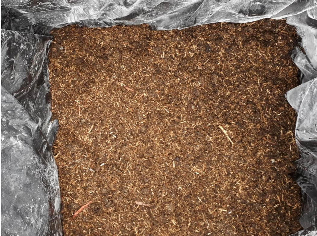
Foto N° 07 Colocación de la capa de sustrato para ambos humedales.
