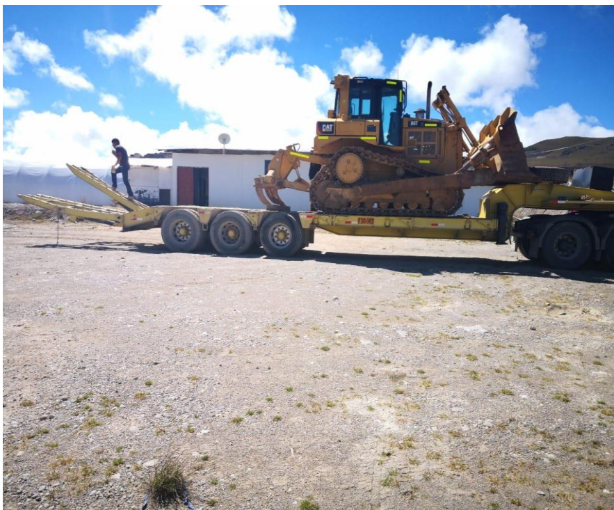
Foto N°21: Maquinaria de la empresa para realizar el Proyecto “Construcción de Pad de Lixiviación en la primera etapa”, lugar la Ciénega perteneciente a Cia Minera Coimolache.
