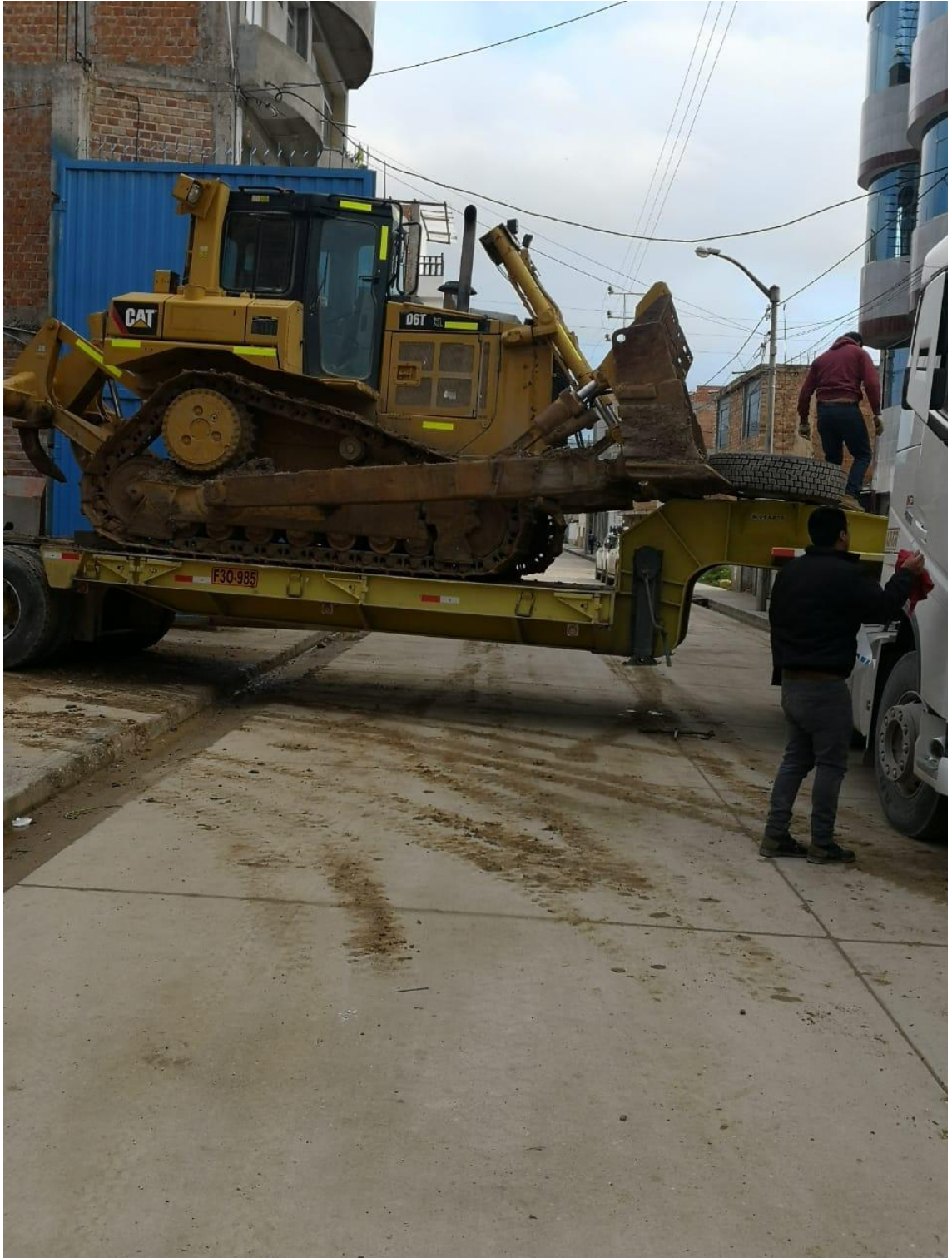
Foto N°18: Transporte de Maquinaria de la empresa para realizar el Proyecto “Construcción de Pad de Lixiviación en la primera etapa”, lugar la Ciénega perteneciente a Cia Minera Coimolache.
