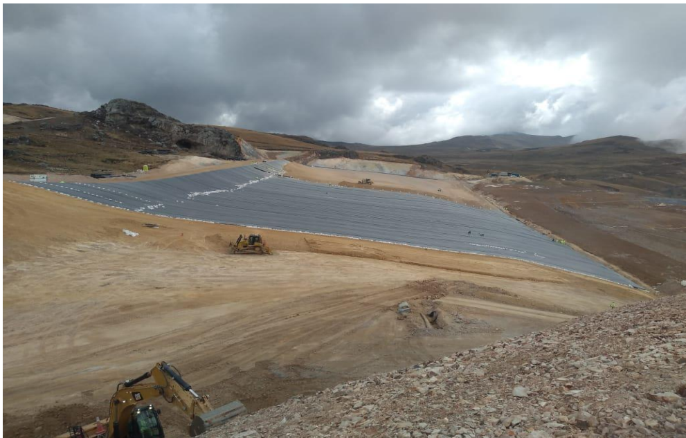
Foto N°26: Extendido de geomembrana “Construcción de Pad de Lixiviación en la primera etapa”, lugar la Ciénega perteneciente a Cia Minera Coimolache.
