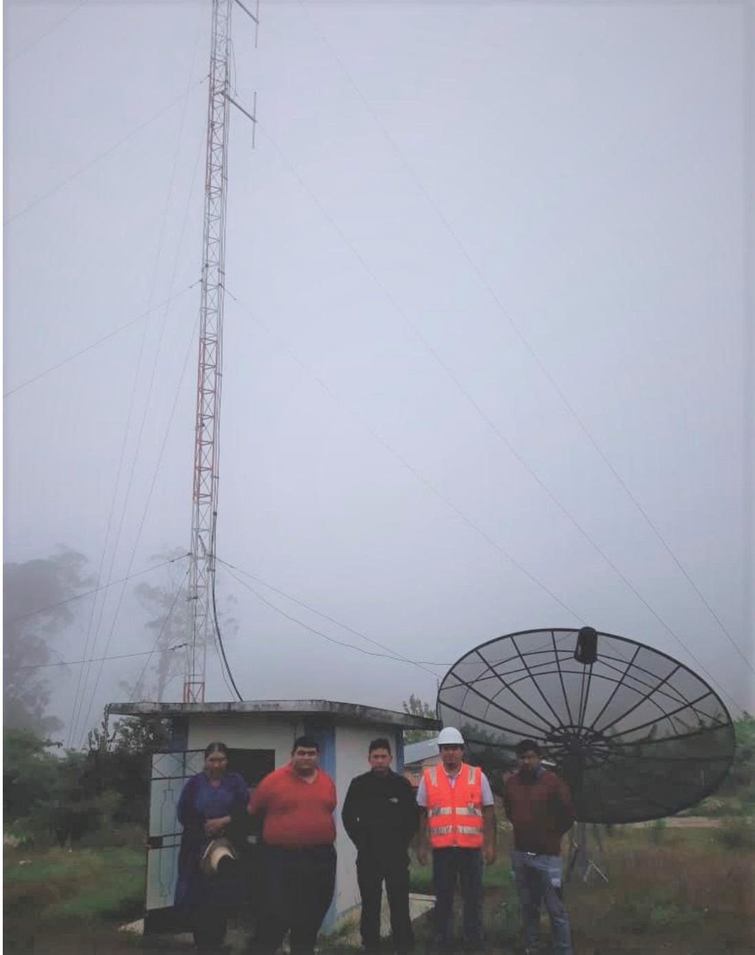
Figura 51: Vista panorámica del sistema de Recepción Satelital y retransmisión de la señal de TV Perú y Radio Nacional.
