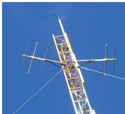
Figura 37: Instalación Antenas de TV.
