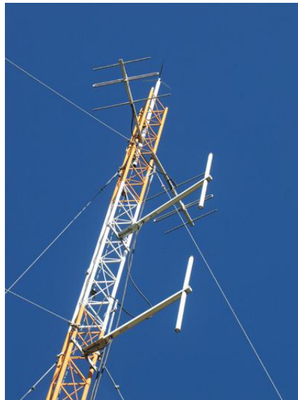
Figura 38: Instalación de las antenas Dipolo.
